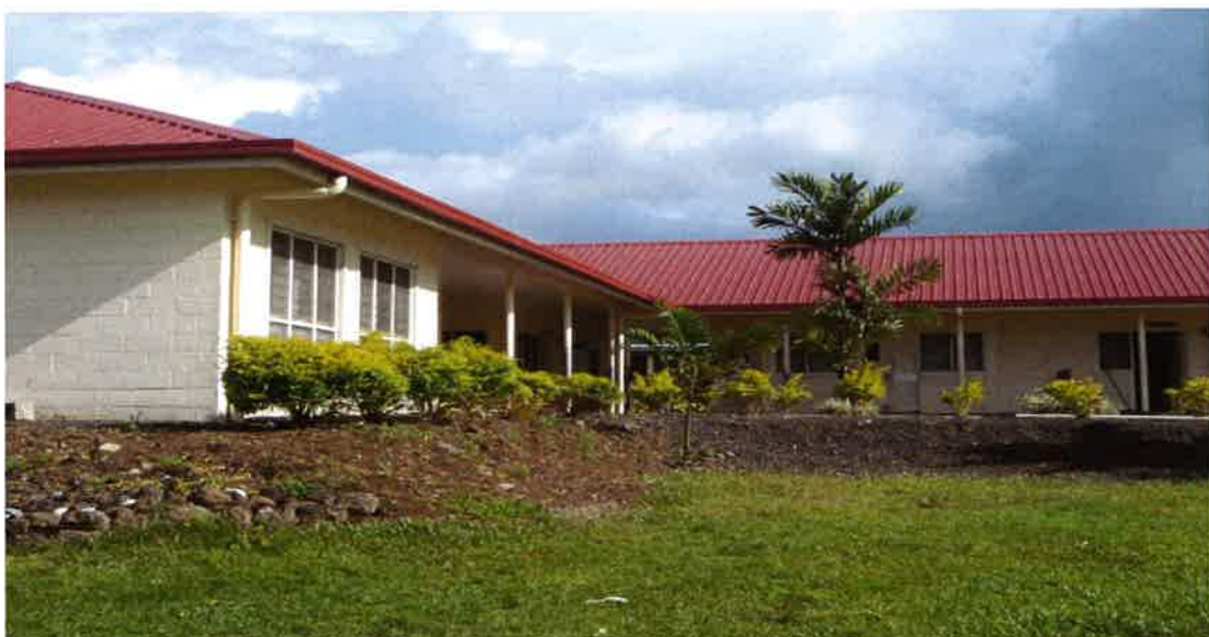
津波が、目前に迫った地方病院。この病院の前方部分は、一部完全に流された
